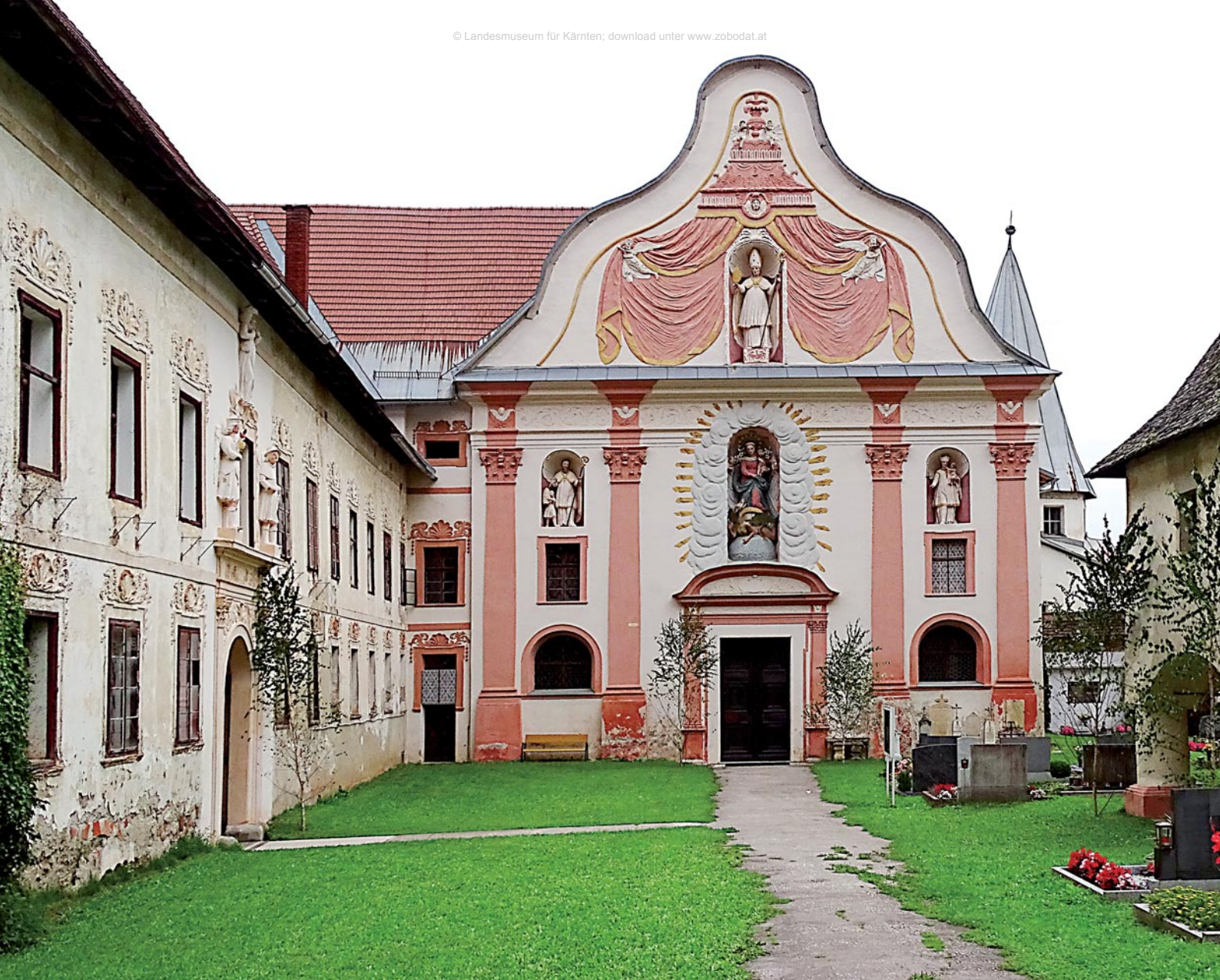
Abb. 5: Fassade der Neuen Stiftskirche und Seitentrakt der Prälatur des ehemaligen Prämonstratenserklosters Griffen, Anfang 18. Jahrhundert. Aufn. R. Wlattnig
