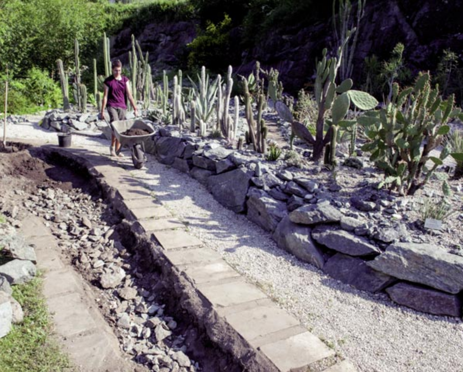
Abb. 7: Abtransport des Aushubs durch Daniel Luttenberger und Einbringung einer Dränageschicht für den neuen Teil des Quartiers für Sukkulente aus der Neuen Welt. Aufn. R.K. Eberwein
