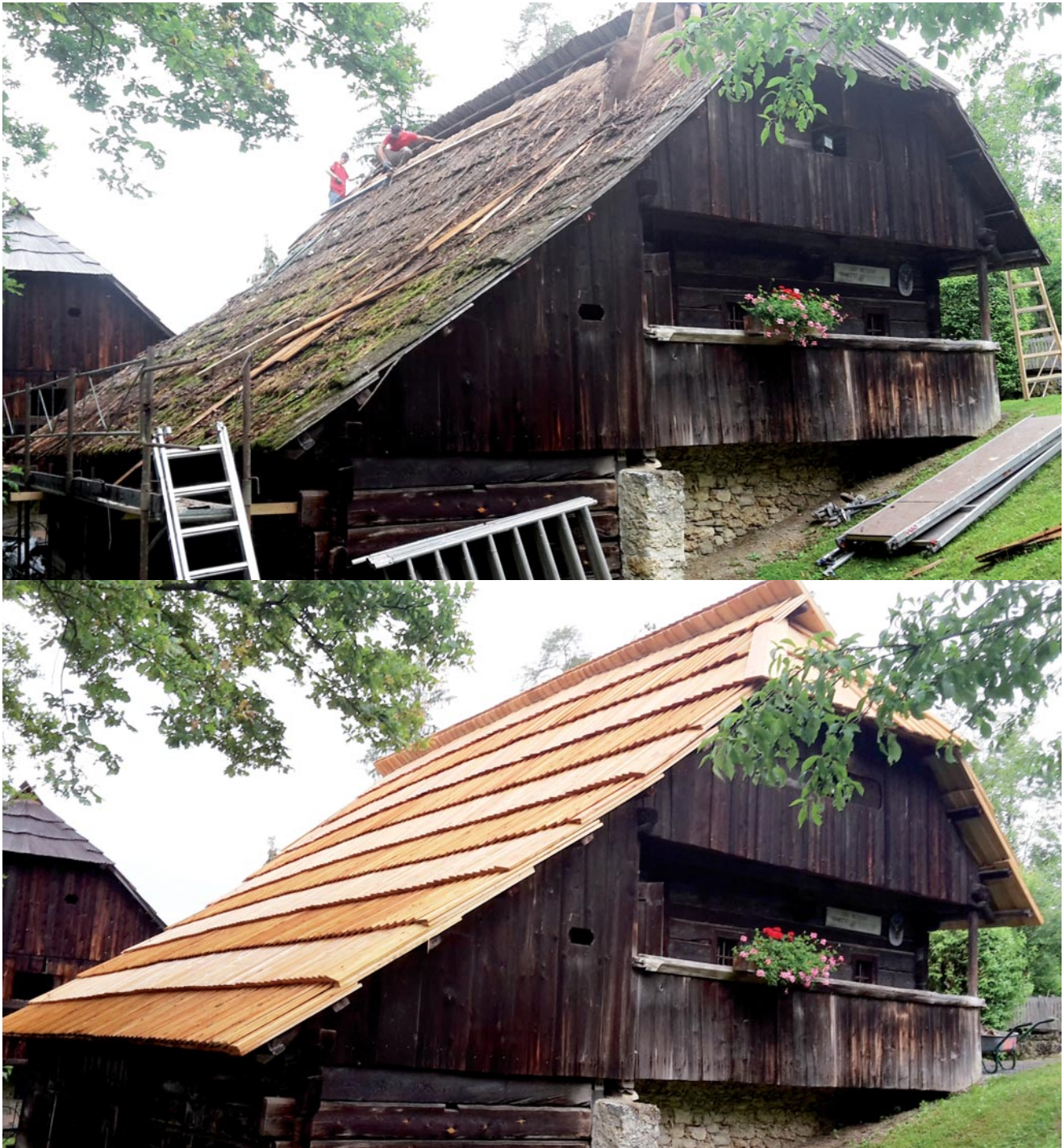
Abb. 1: Dachsanierung Urchhaus. Aufn. LMK
