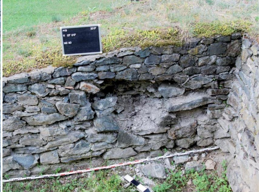
**Abb. 1b:** NG 40 großflächige Ausbrüche der Mauerschale. Zustand vor der Restaurierung (K. Gruber, A. M. Mitterdorfer 2017)
