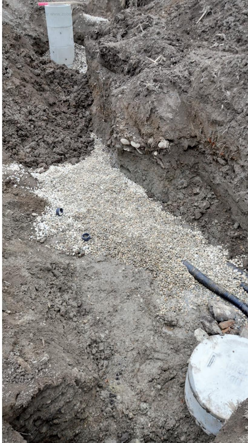
**Abb. 8:** Neue Quellwasserefassung und -einleitung in den antiken Kanal (H. Dolenz/LMK 16.03.2017)
