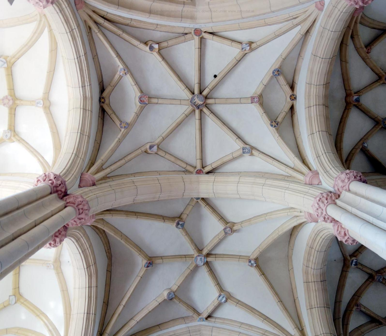
**Abb. 3:** Sternrippengewölbe mit Wappenschlusssteinen im Langhausmittelschiff der Wallfahrtskirche von Hochfeistritz, kurz vor der ersten Einweihung der Kirche 1487; LMK. Aufn. R. Wlattnig
