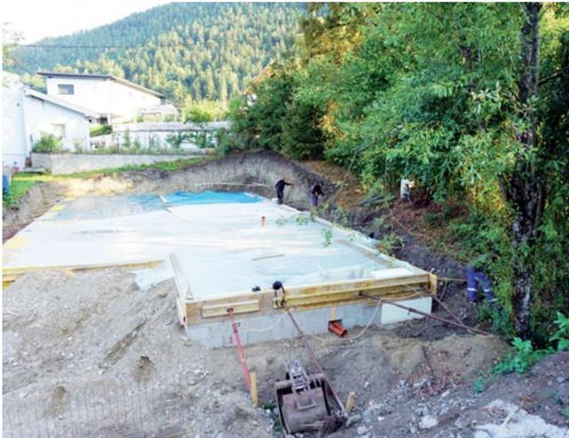
**Abb. 2:** Baufläche mit Fundamentplatte und dahinterliegenden Profilen. Aufnahme aus Süden, D. Ebner-Baur, LMK
