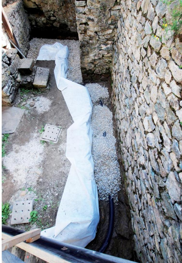
**Abb. 4:** Neu eingebrachtes PVC-Rohr mit Riesel und ummantelndem Bauflies. Aufnahme aus Norden, D. Ebner-Baur, LMK
