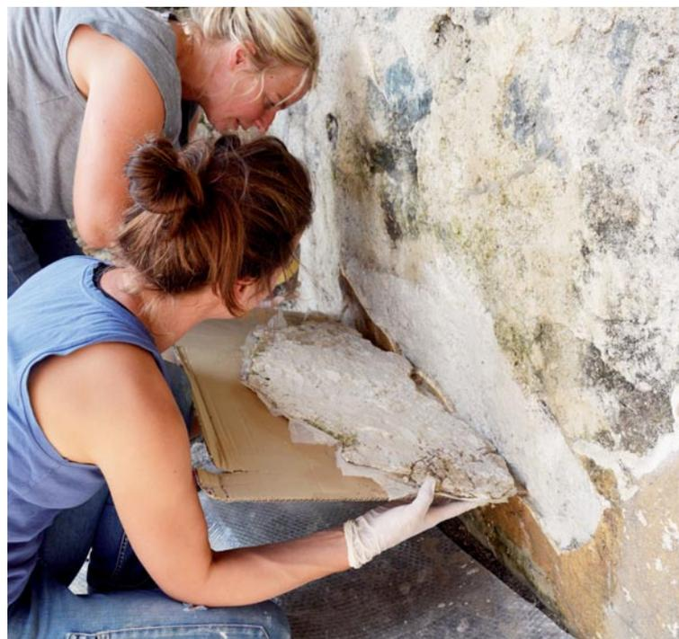
**Abb. 35:** Abnahme und Wiederversetzen von Putzteilen. Aufn. L. Huck, A. Sagmeister
