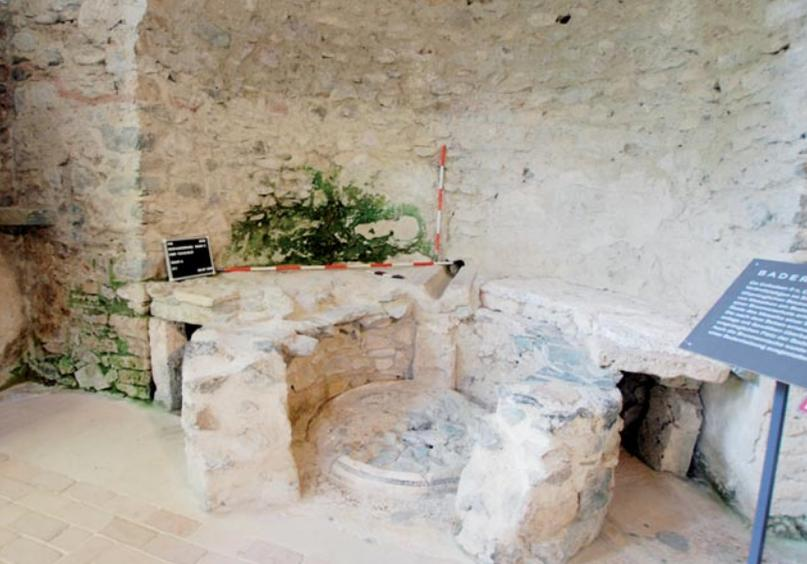
**Abb. 2:** Grünalgenbildung an der Westmauer und in der Apsis im Raum A (M1)/Calgarium. Aufnahme aus Nordosten, D. Ebner-Baur, LMK
