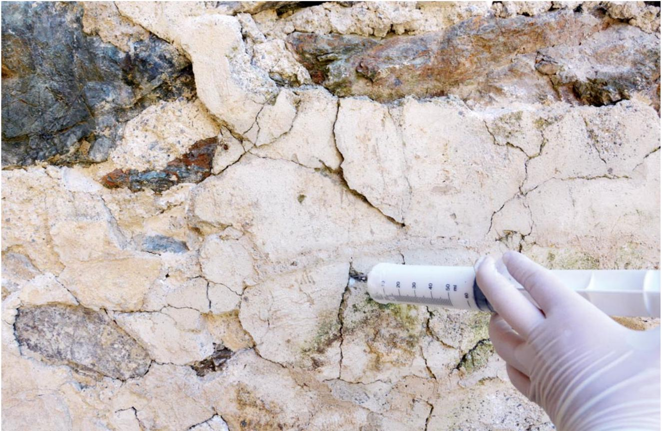
Abb. 36: Injektion von Kalkmörtel zur Wiederanbindung des Putzes an das Mauerwerk. Aufn. L. Huck, A. Sagmeister
