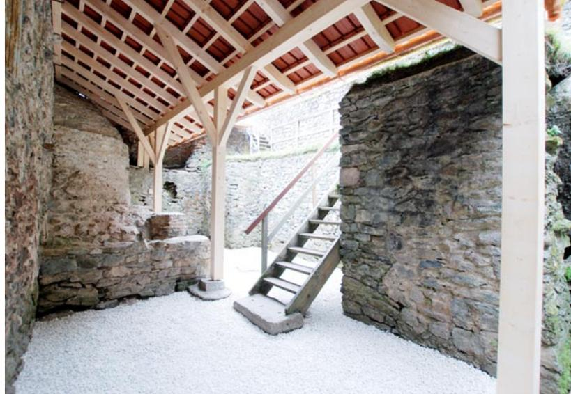
**Abb. 7:** Weiß gekiester Hofbereich E mit neuer Dach-konstruktion. Aufnahme aus Nordosten, D. Ebner-Baur, LMK
