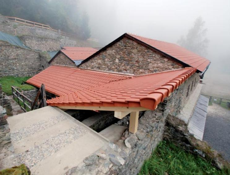
**Abb. 6:** Erneueres Betonpodest mit durch Kieseinlage ange-deutetem Terrazzoboden. Aufnahme aus Südwesten, D. Ebner-Baur, LMK
