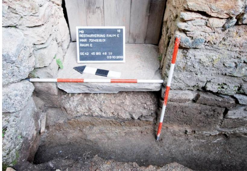
**Abb. 12:** Profil unter der Marmorschwelle (SE59): Mörtel-terrazzo, Holzkohlestratum, Planier- und Bauhorizont (SE42, 45, 46, 47 und 47A) und opus quadratum-Technik der M1. Aufnahme aus Westen, D. Ebner-Baur, LMK
