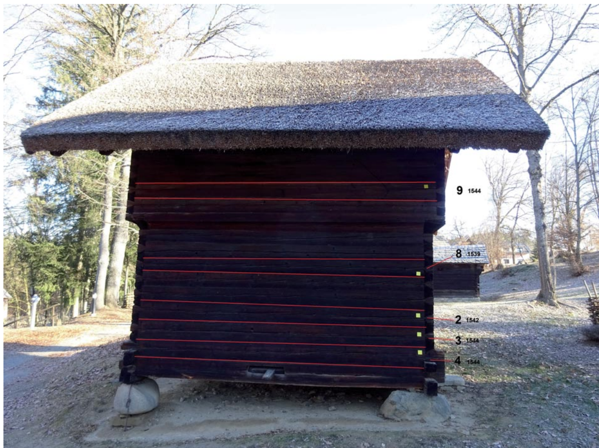
Abb. 5: Fotografik Mörtlbauerkasten – datierte Wandhölzer rot ausgewiesen Proben 01 (1539), 02 (1542), 08 (1539).
