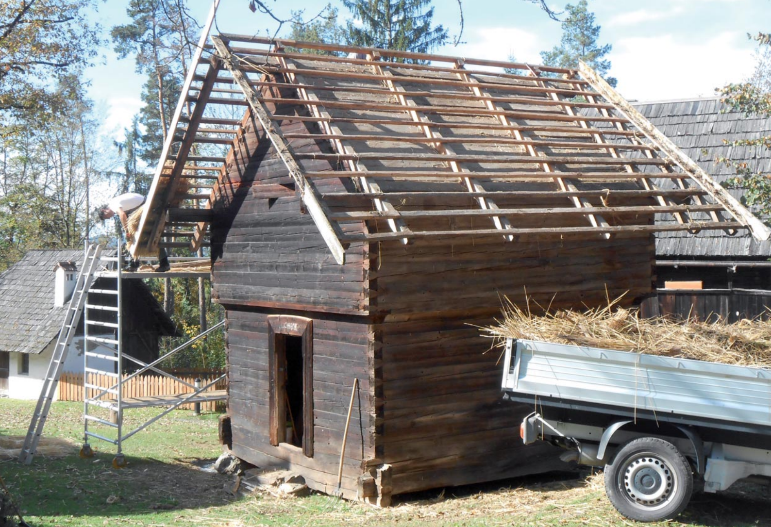
Abb. 2: Mörtlbauerkasten – bei der Neueindeckung des Strohdaches (2014) ist die durchgezimmerte Decke deutlich zu sehen. Aufn. LMK
