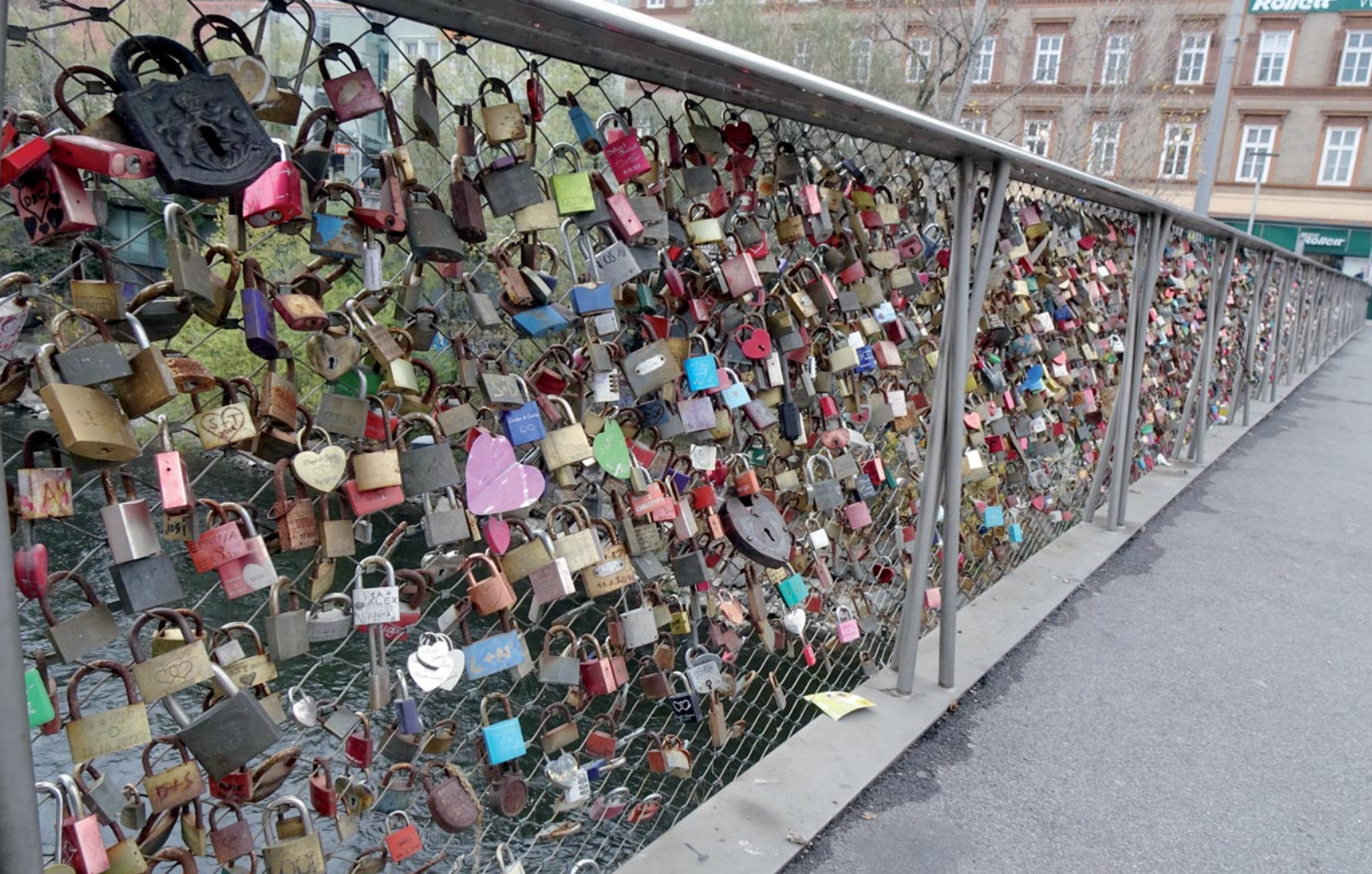
Abb. 6: Graz, Hauptbrücke. Aufn. H. Schinnerl, 2019
