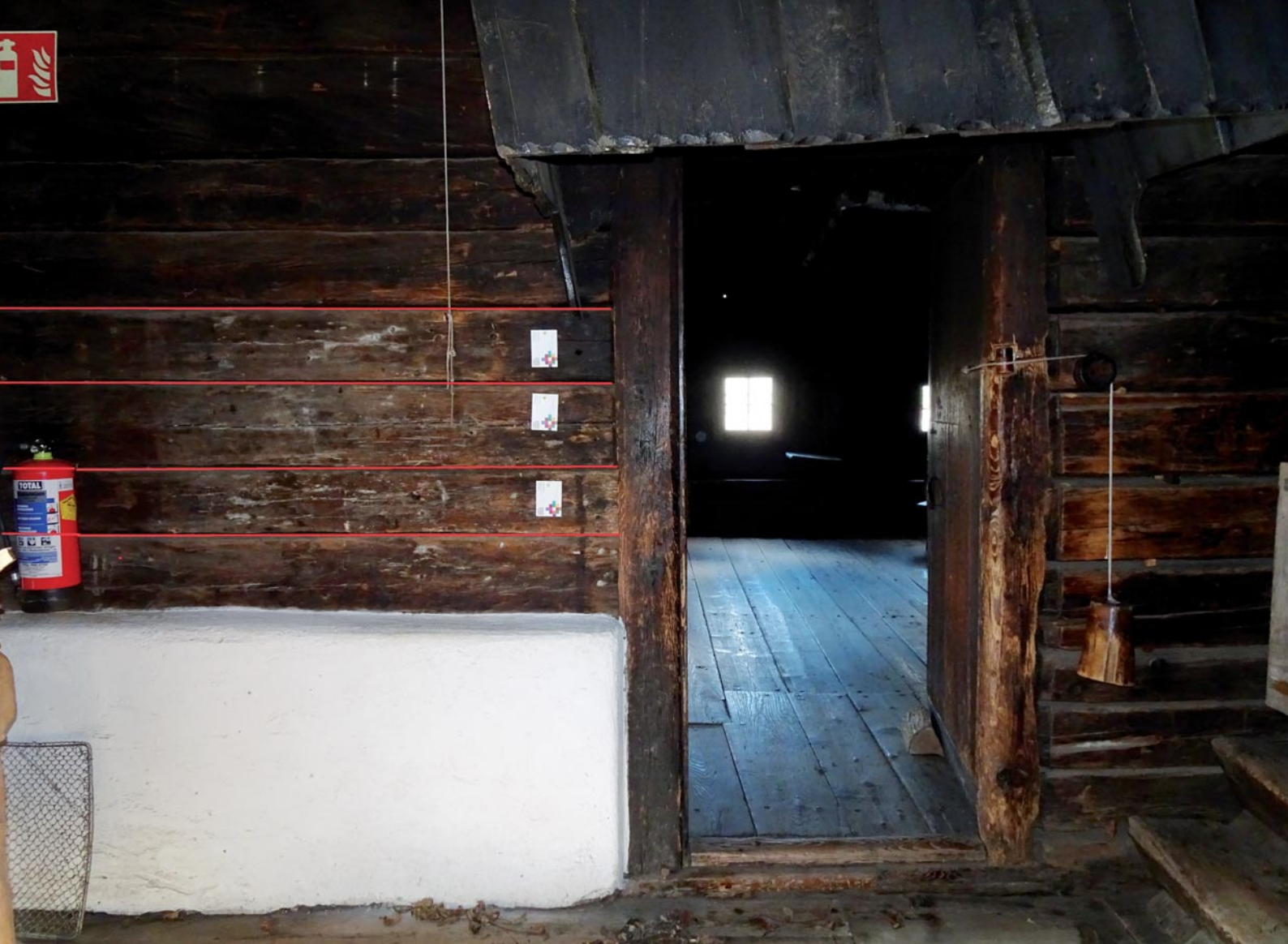
Abb. 4: Wandbalken 2 (1654), 3 (1645), EG, in der „Labm“. Aufn. H. Schinnerl
