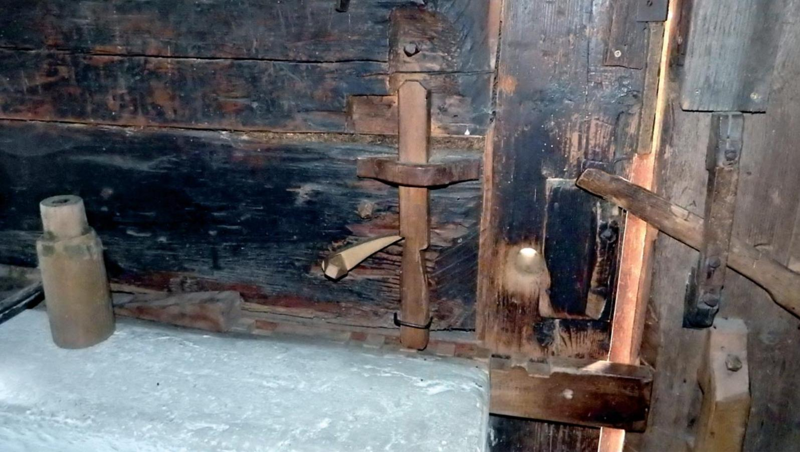
Abb. 11: Riegelschloss bei der Eingangstür. Aufn. J. Schwertner
