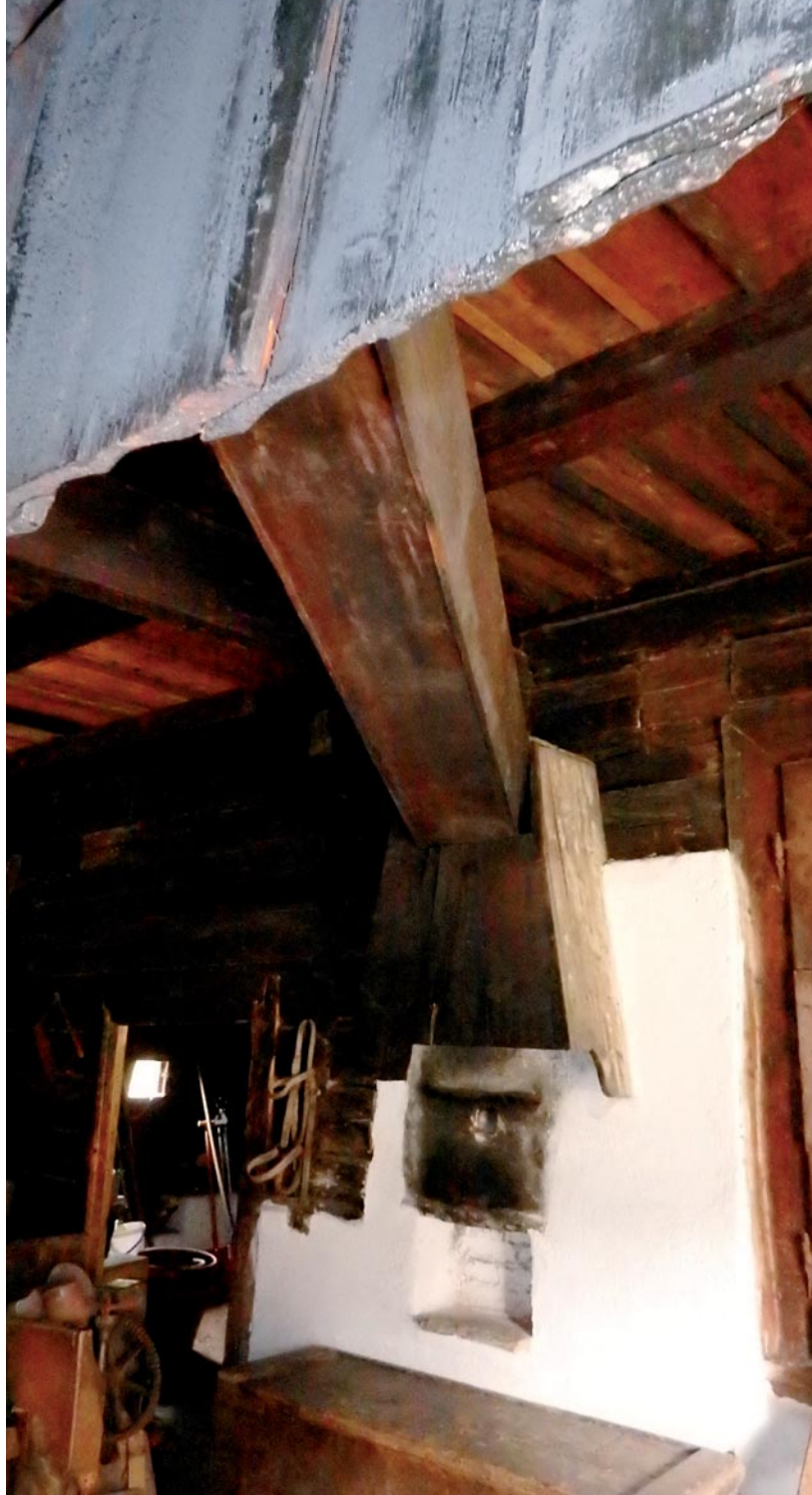
Abb. 9: Rauchgang zum hölzernen Kamin im Vorraum des Kramerhauses. Aufn. J. Schwertner
