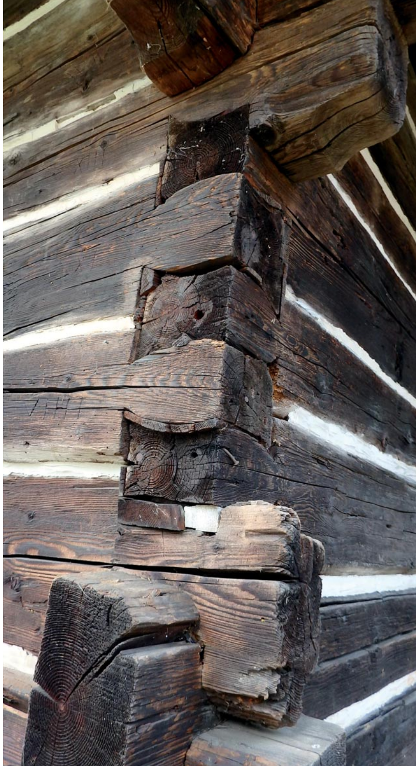
Abb. 5: Klingschrot als Eckverbindung beim Kramerhaus. Aufn. J. Schwertner
