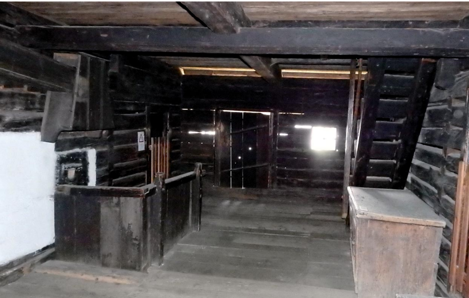
Abb. 12: Vorraum im Obergeschoss des Kramerhauses. Aufn. J. Schwertner
