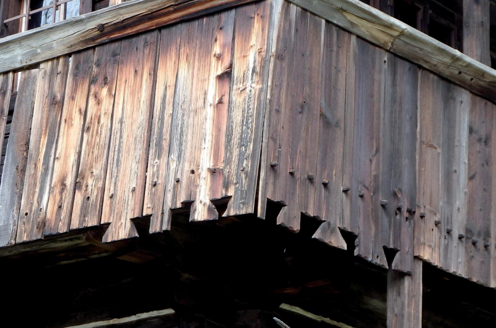
Abb. 13: „Ziegenbart“ als Auszier an den südlichen Ecken des Balkones im Obergeschoss. Aufn. J. Schwertner
