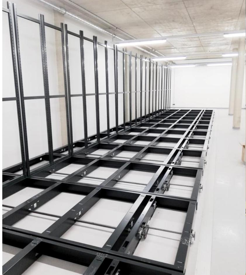
Abb. 3 u. 4: Rollanlage beim Aufbau und nach Fertigstellung. Aufn. C. Dojen, LMK
