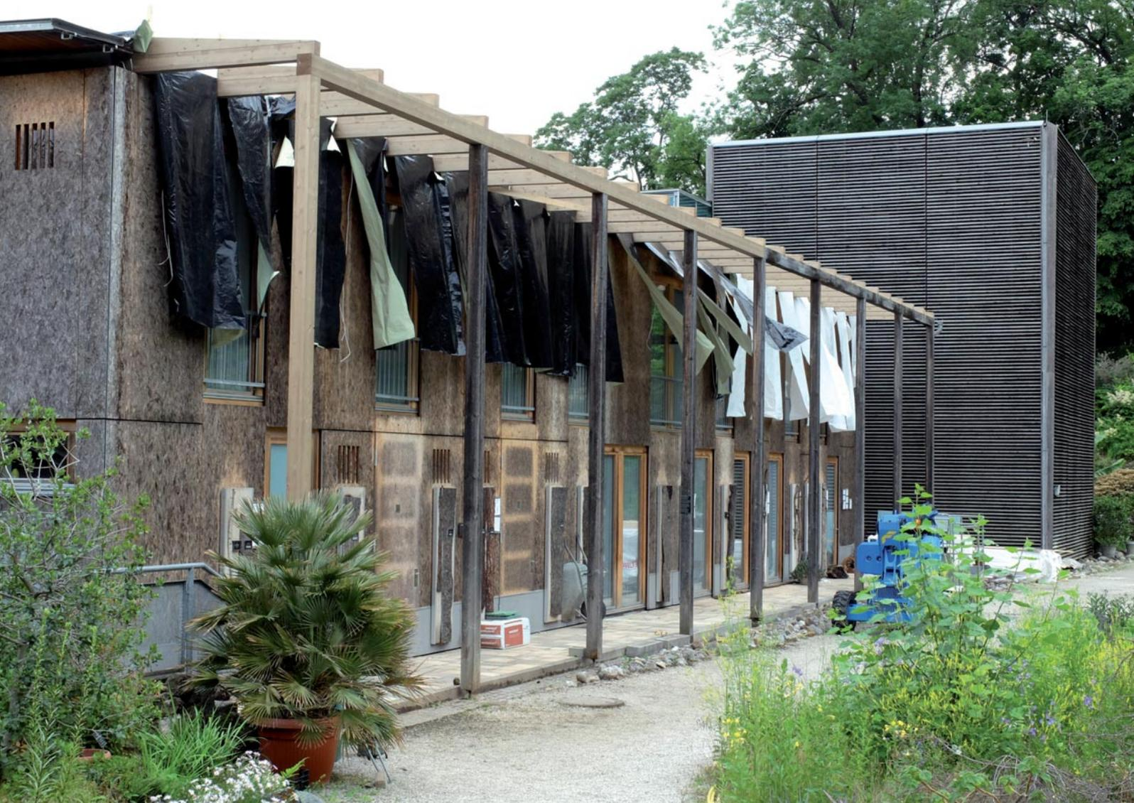
**Abb. 1:** Provisorische Abdichtung des Hausdaches mit Planen nach erfolgter Entfernung des Vordaches. Aufn. LMK-KBZ Roland K. Eberwein
