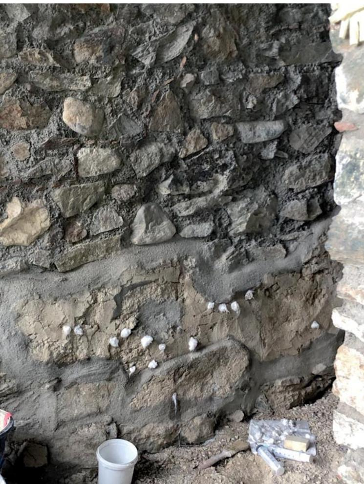
Abb. 2: Gebäude AA/36: Mit Watte verschlossene Injektionslöcher in Putz mit starken Fröhschwundrissen. Aufn. L. Huck
