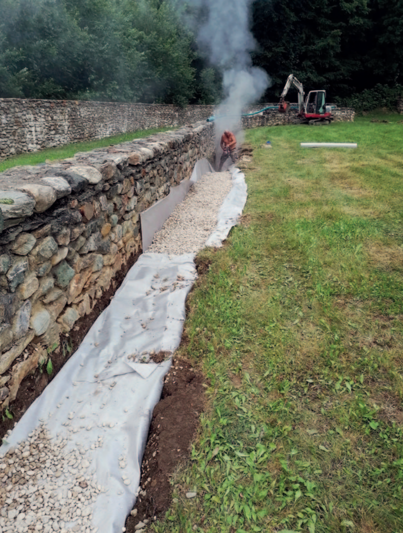
Abb. 9: Erneuerung der Drainage entlang der westlichen inneren Caveamauer. Aufn. Wolfgang Schnitzler, km
