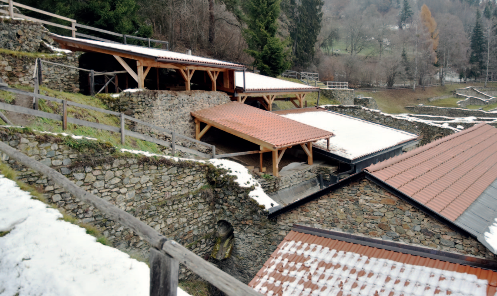
Abb. 2: Neubedachung Raum V im Jahr 2022 (Dach ohne Schnee). Ansicht von Südwesten. Aufn. Andreas Kall, km
