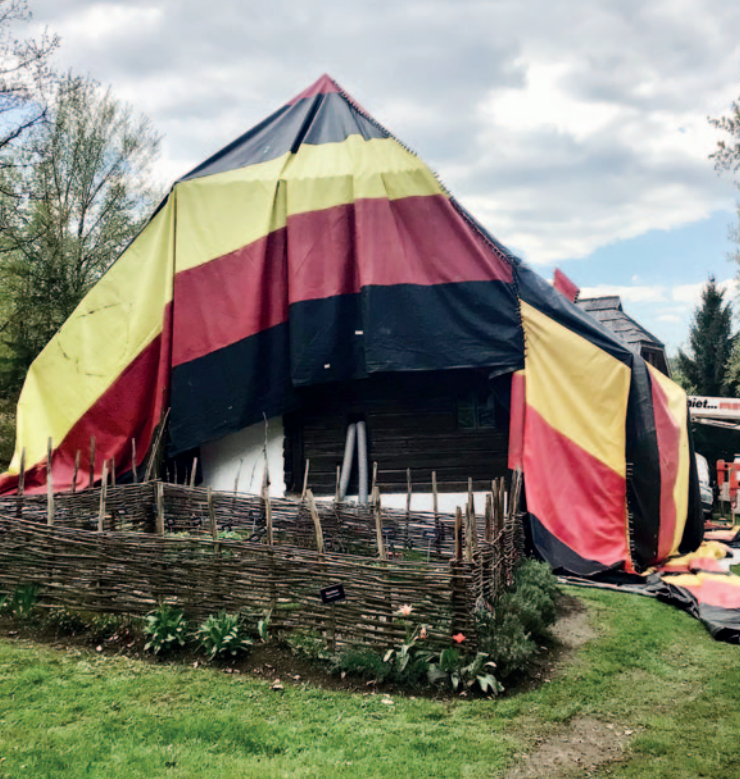
Abb. 2: Bekämpfung des Holzwurmes mittels eines Begasungsverfahrens. Aufn. M. Tschinder, privat
