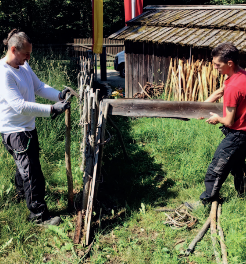
Abb. 4: Zaunreparatur hinter dem Kassengebäude durch Angelo Obernosterer und Jürgen Trapp. Aufn. M. Tschinder, privat
