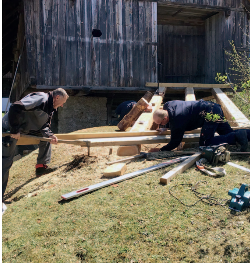
Abb. 3: Sanierung der Tennbrücke beim Skorjanzstadel durch die Fa. Baumgartner. Aufn. M. Tschinder, privat
