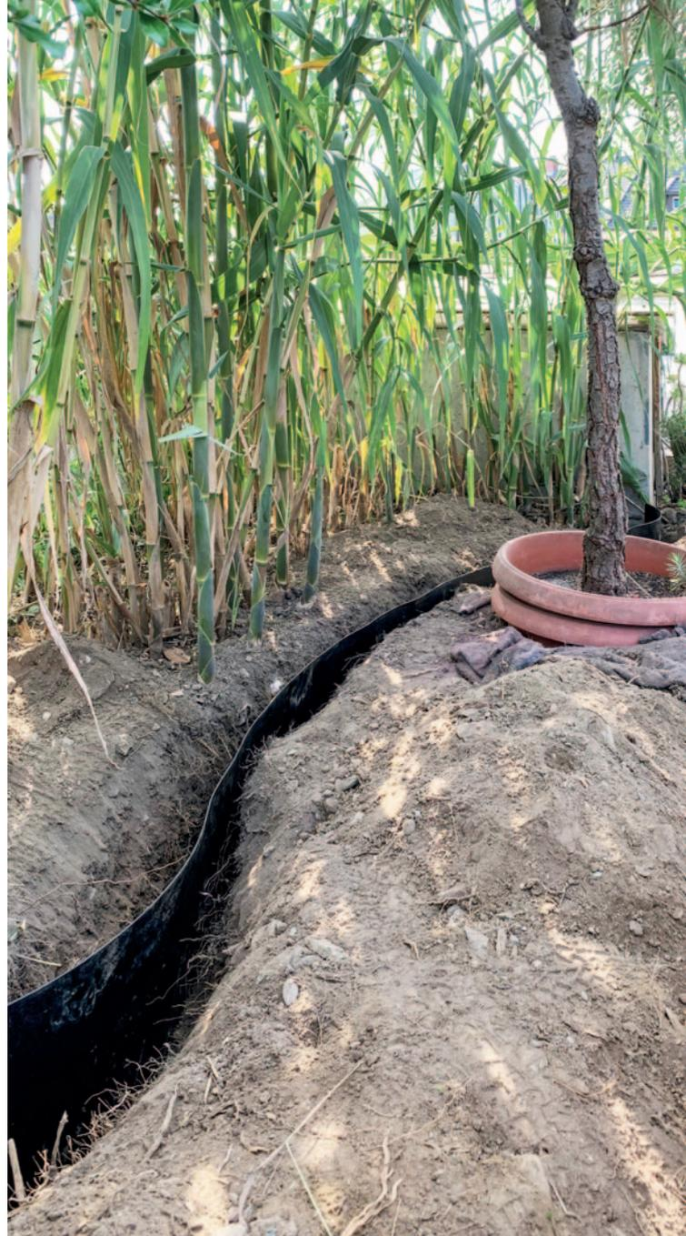
**Abb. 4:** Eingegrabene Rhizomsperr für das Pfahlrohr, *Arundo donax*. Aufn. Anna F. Klammer
