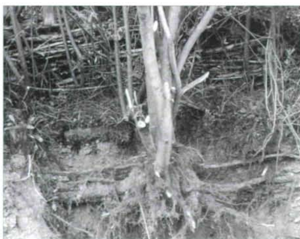
Abb. 12: Wurzelbildung bei einem Flechtzaun, der zum Uferschutz gebaut wurde. 12 Jahre alt.
