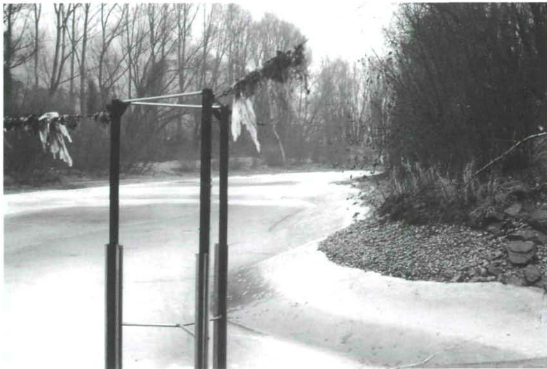
Abb. 87: Niederwassersituation im Altarm; bei geringer Wasserführung der Donau sinkt auch der Wasserspiegel im Altarm unter das Sohlniveau des Rohrdurchlasses.
