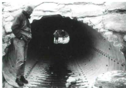
Abb. 4: Oberstromiger Rohrdurchlaß bei Niederwasser.
