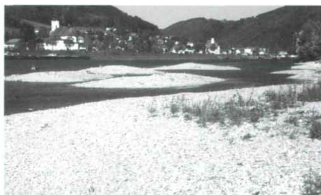
Abb. 9: Wasseranschlagsbereich bei Strom-km 2199,5 am linken Ufer nach der Strukturierung.
