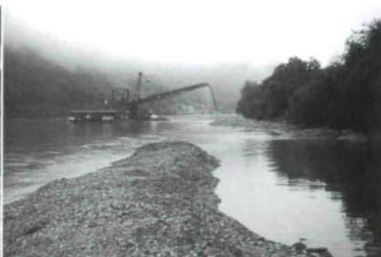
Abb. 3: Schutenentleerer „Ressl“ bei der Schüttung.
