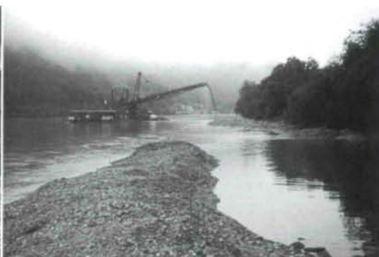
Abb. 3: Schutenentleerer „Ressl“ bei der Schüttung.
