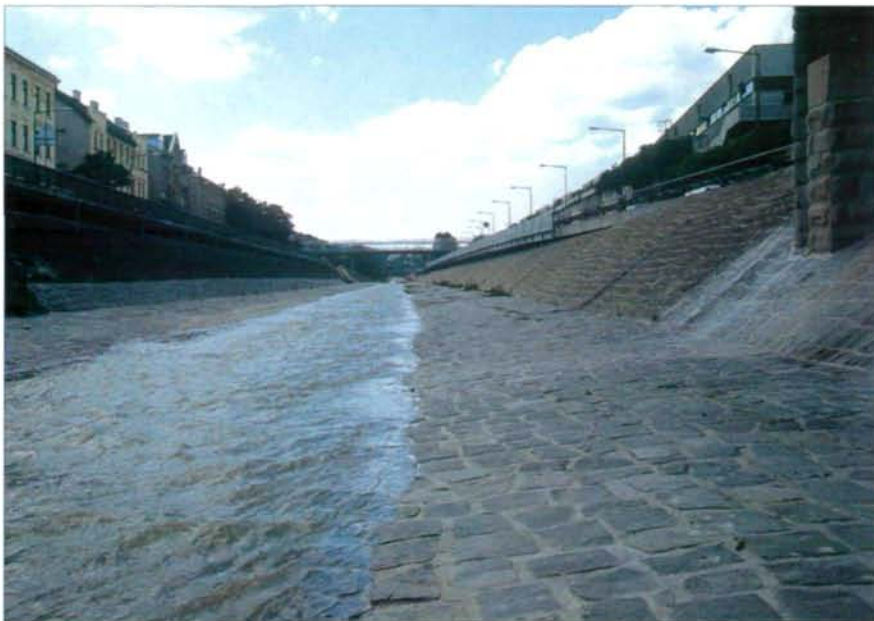
Abb. 3: Wienfluß. Dieses Gewässer ist nach der Durchführung von Hochwasserschutzbauten von vereinheitlichten Strömungsverhältnissen, fehlenden Versteckmöglichkeiten und denaturierten Ufern geprägt. Für Krebse und viele andere Fließgewässerorganismen ist dieser Gewässerabschnitt nicht besiedelbar. Foto: F. STREIBL.
