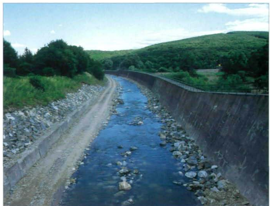
Abb. 5: Wienfluß. Nach erfolgtem Rückbau weist das Bachbett wieder heterogene Strömungsverhältnisse und mögliche Unterstände für Krebse auf. Die Ufer sind jedoch weiterhin in einem naturfremden Zustand. Foto: F. STREIBL.
