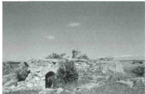
Abb. 4: Ruinen und Trümmerfelder weisen einen im Vergleich zu den umgebenden Trockenrasen auffallenden Gehölzbewuchs auf. Foto: G. Bieringer
