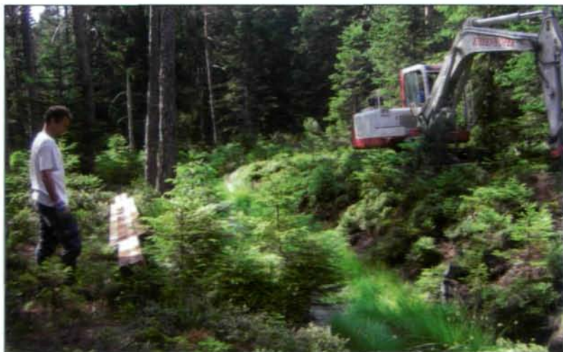
Abb. 10: Der Einbau der Sperren erfolgte zur Schonung der Mooroberfläche immer nur von einer Seite des Grabens aus (Foto: I. ORTNER)
