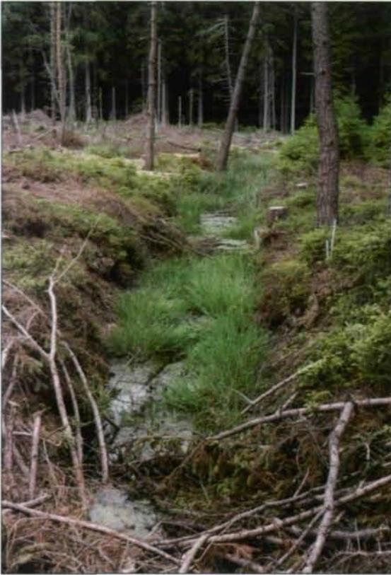
**Abb. 19:** Die Bereiche um Graben C sind freigestellt und bereit für den Einbau der Sperren.
