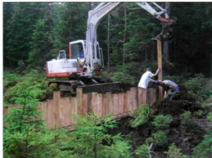
Abb. 16: Die Grabensperre steht kurz vor ihrer Fertigstellung und wird anschließend fest verschraubt. (Foto: I. ORTNER)
