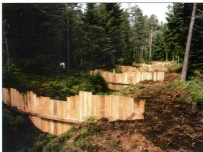
Abb. 17: Fast fertige Sperren im Graben E. Noch ist kein Anstieg des Wasserspiegels zu bemerken. (Foto: M. PÖSTINGER)
