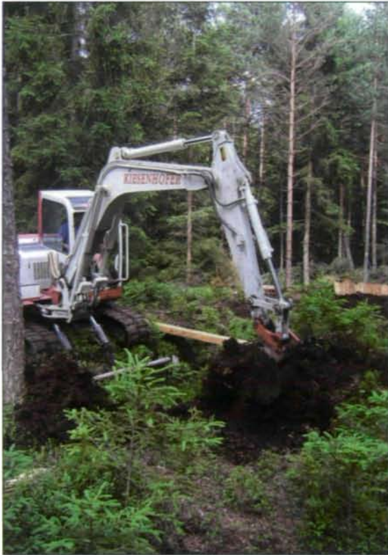
Abb. 11: Bevor mit dem eigentlichen Einbau begonnen werden konnte, musste zuerst ein entsprechendes Bett ausgehoben werden (Foto: I. ORTNER)
