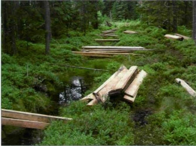
ckelt, um die Befahrung der Mooroberfläche auf ein Minimalmaß zu reduzieren. So erfolgte etwa der Einbau der Grabensperren immer nur von jener Seite aus, wo das Aushubmaterial aus den früheren Räumungen entlang der Gräben deponiert wurde.
