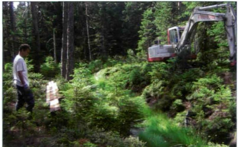
**Abb. 10:** Der Einbau der Sperren erfolgte zur Schonung der Mooroberfläche immer nur von einer Seite des Grabens aus (Foto: I. ORTNER)
