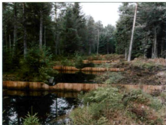
Abb. 18: Etwa 4 Wochen nach dem Einbau wird das Wasser effektiv im Moor zurückgehalten. (Foto: M. PÖSTINGER)
