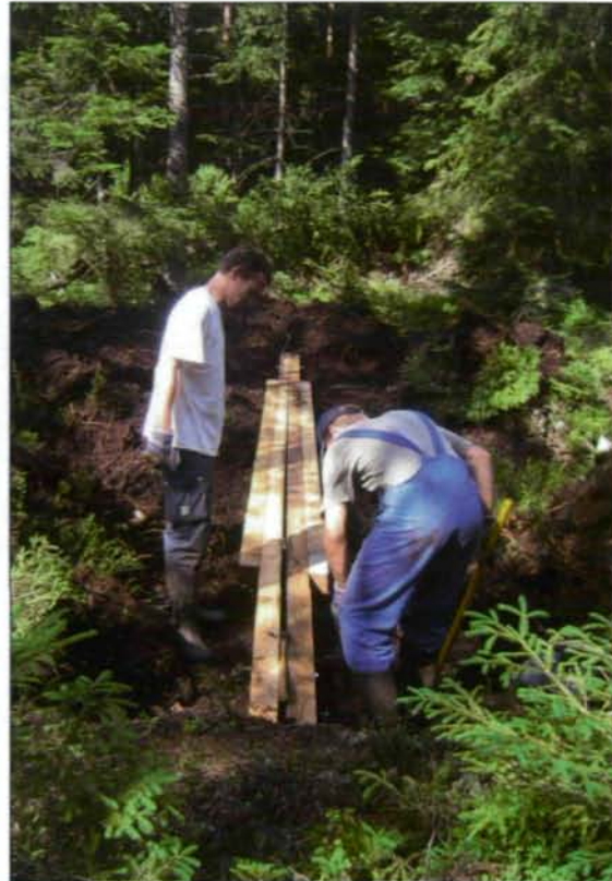
Abb. 12: Die Kantholz-Führungsschiene wird in Position gebracht. (Foto: I. ORTNER)
