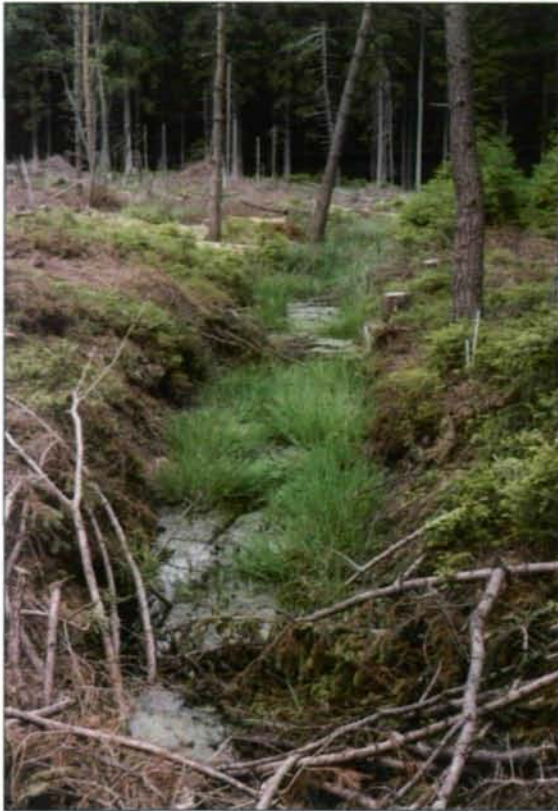
Abb. 19: Die Bereiche um Graben C sind freigestellt und bereit für den Einbau der Sperren. (Foto: M. PÖSTINGER)
