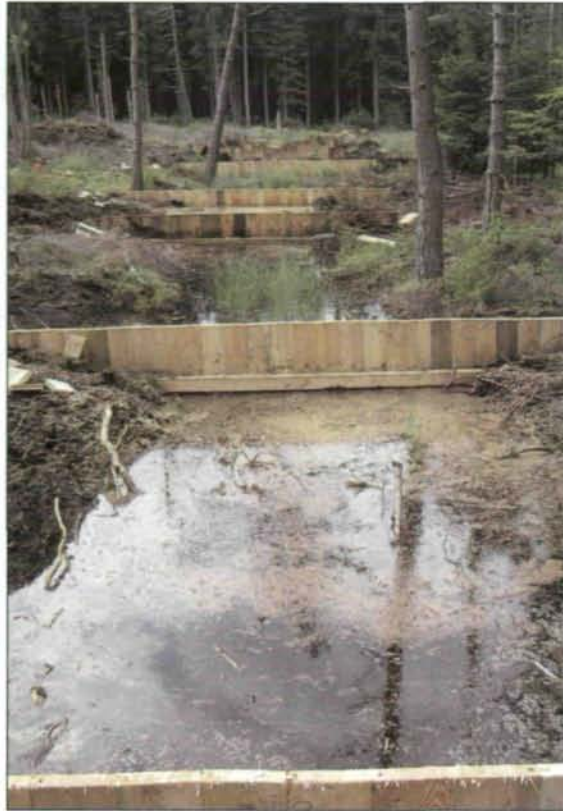
Abb. 20: Bereits nach nur einem Tag stand das Wasser in Graben C unmittelbar unter der Mooeroberfläche. (Foto: M. PÖSTINGER)
