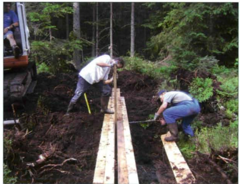
Abb. 14: Kantholz und Pfosten werden durchbohrt und zur Fixierung mit einer Gewindestange verschraubt (Foto: I. ORTNER)
