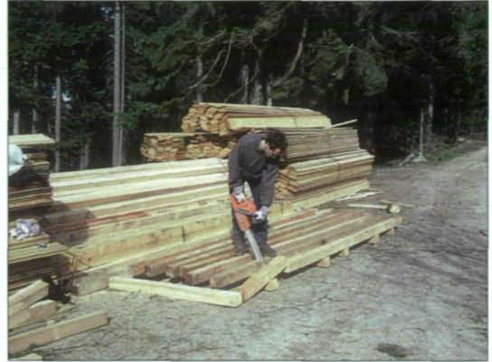
Abb. 7: Bevor das Baumaterial ins Moor transportiert werden konnte, wurden die verschiedenen Einzelteile einer genauen Arbeitsvorschrift entsprechend zugeschnitten. (Foto: C. AICHBERGER)
