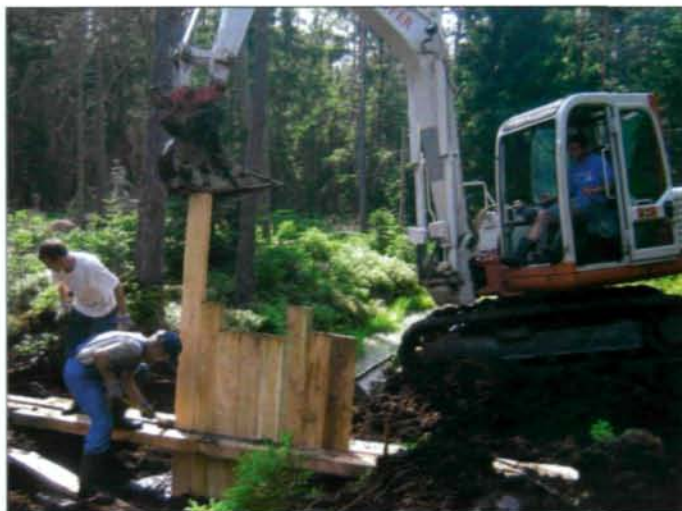
Abb. 15: Nach und nach werden die weiteren Pfosten unter ständiger Kontrolle im Torf versenkt. (Foto: I. ORTNER)
