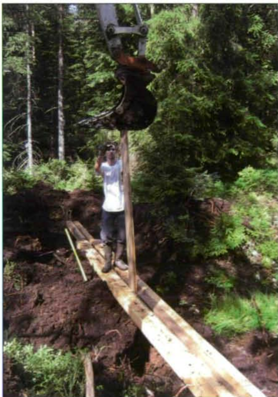
Abb. 13: Durch leichten Druck mit dem Baggerlöffel wird vorsichtig der zentrale Pfosten gesetzt (Foto: I. ORTNER)
