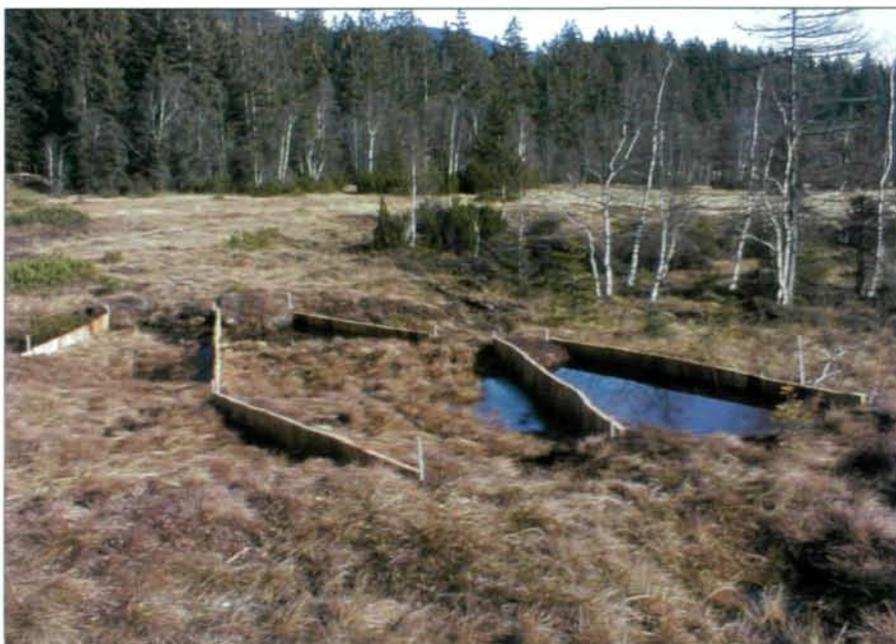
der Auswaschung der seitlichen Ränder entgegen zu wirken, kann man in der Mitte des Dammes einen Überlauf herausschneiden. Damit wird bei hohen Wasserständen der Druck auf den Damm etwas gemindert.
