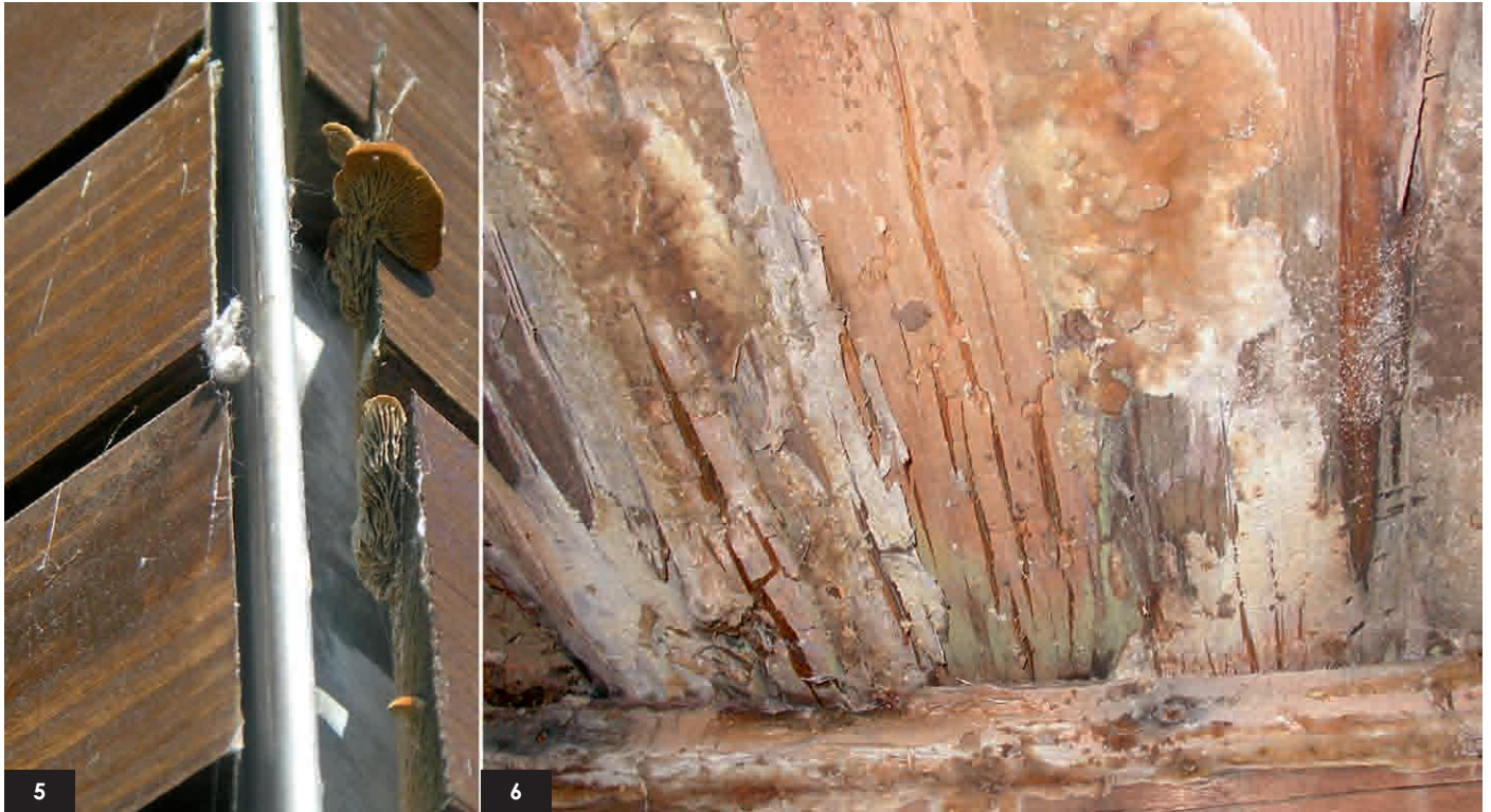
Abb. 5-6: Gloeophyllum sepiarium : 5: Fruchtkörper an einer Holzfasade. 5: Dunkelform von Gloeophyllum sepiarium mit ausgeprägter Braunfäule in einer Zwischendecke verursacht durch eine undichte Duschwanne.
