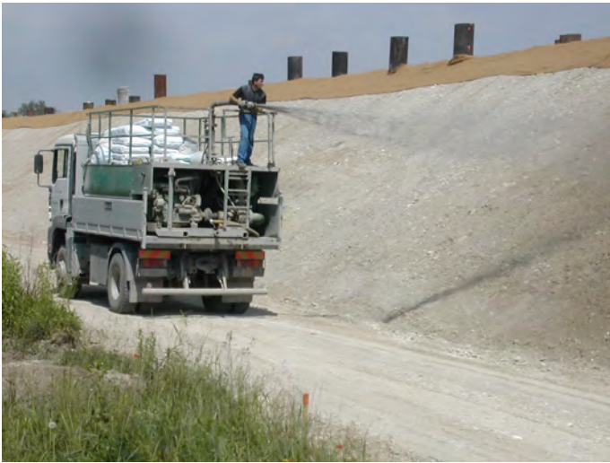
Abb. 2: Ausbringung des Saatgutes (Strohmulchsaat) im Anspritzverfahren ( www.hydrogreen.at ). An der Hangschulter: Kosmatten gegen Erosionen. Juni 2005.
