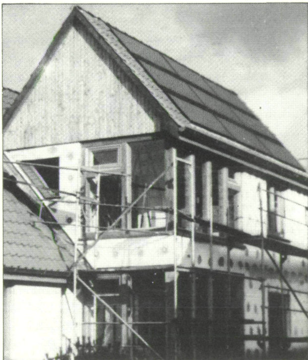
Bild 7 Beispiel einer Kollektoranlage für solare Übergangsheizung in Bad Schwartau bei Lübeck, geogr. Breite 54°
