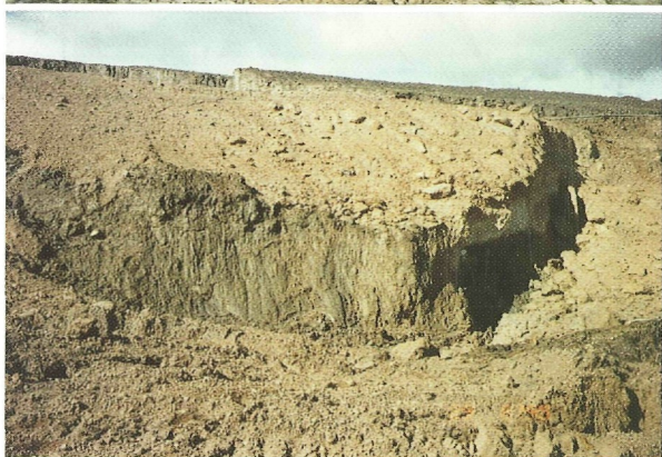
Abb. 5: Anwendung der WSF-Aschen zur Abstützung und Befestigung eines Rutschungsbereiches des Braunkohletagbaues Barbara
