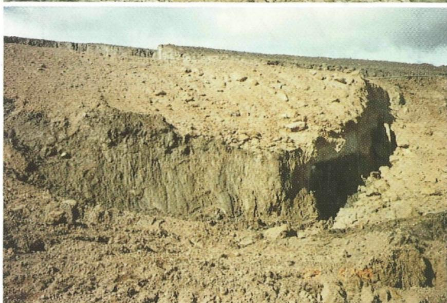
**Abb. 5:** Anwendung der WSF-Aschen zur Abstützung und Befestigung eines Rutschungsbereiches des Braunkohletagbaues Barbara
