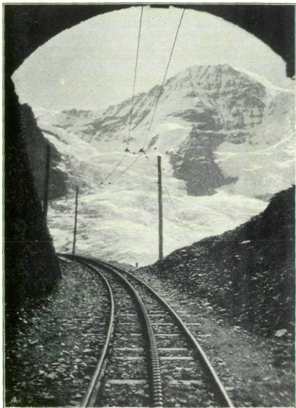
Blick aus dem ersten Tunnel der Jungfraubahn gegen den Mönch (4105 m).
