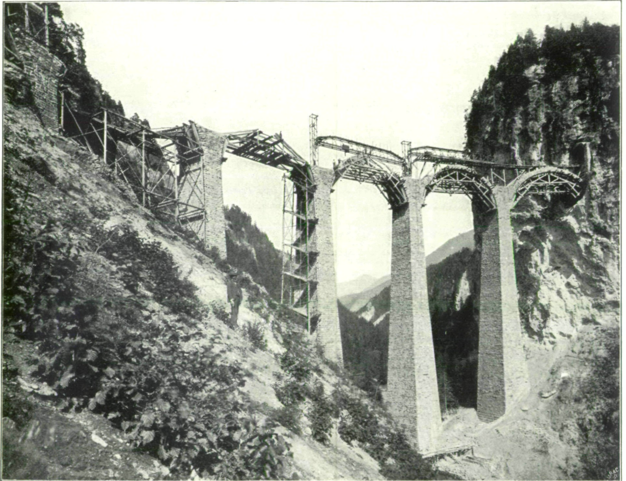
Landwasserviadukt im Baue.
