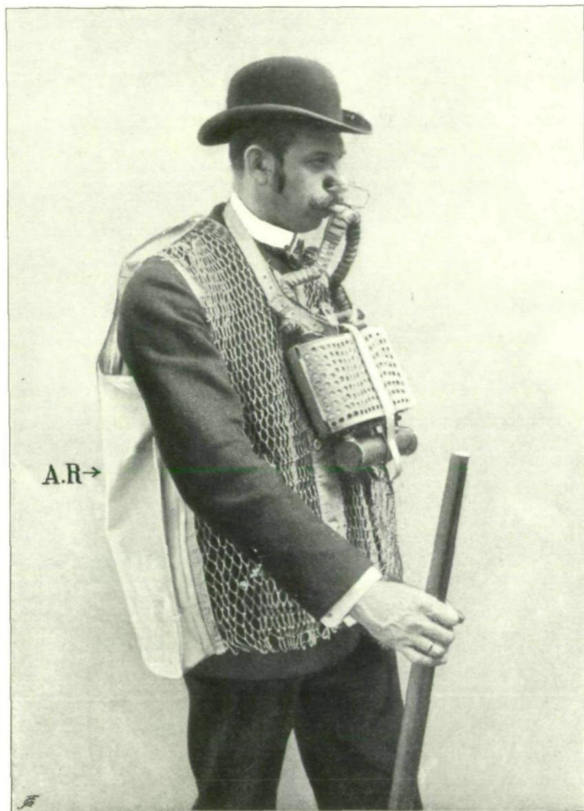
Atmung mit dem „Arbeits“-Apparat (Pneumatogen Type II)
