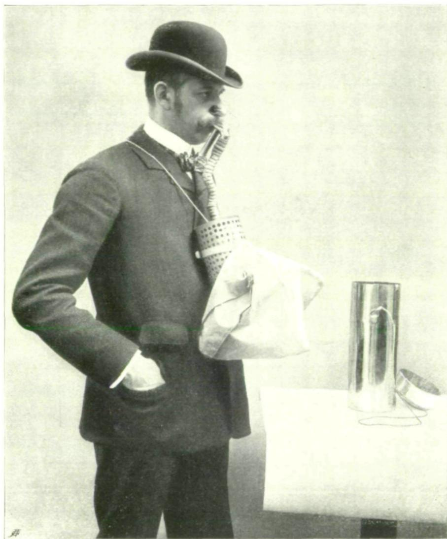
Atmung mit dem Selbststretungsapparat
