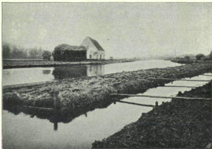
Fig. 4. Typisches Bild der belgischen Lysröste; mehrere Röstkästen im Wasser versenkt.
