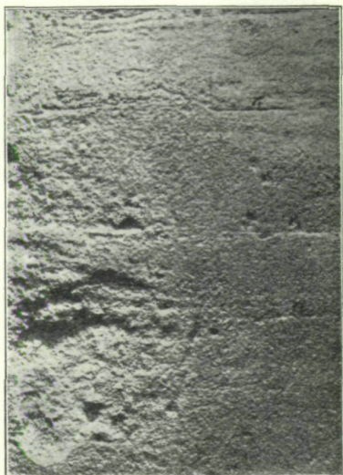
Fig. 1. Sandsteinverwitterung am Kölner Dom.
