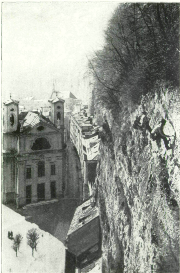
Taf. I. Die „Bergputzer“ am Mönchsberg bei Salzburg. Im Frühjahr wird das durch die Fröste gelockerte Gestein entfernt, damit es keinen Schaden stiftet. (Auch am Leopoldsberg bei Wien.)
