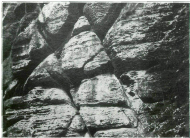
Fig. 14. Verlauf der Verwitterung nach den Klüften und zellige Verwitterung des Quadersandsteines (Bastei, Sachsen).
