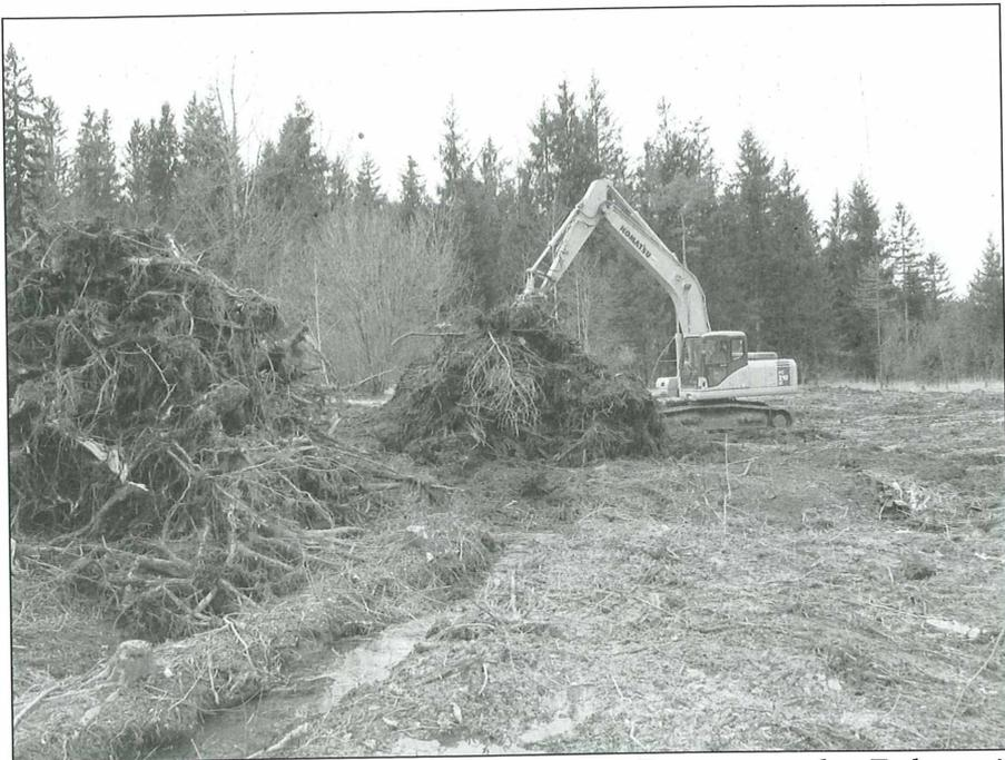
Abb. 12: Die Wurzelstöcke werden von einem Bagger aus der Erde gerissen, abgeschüttelt und am Manipulationsplatz zwischengelagert (15.03.2008; Foto: A. WALDMANN).
