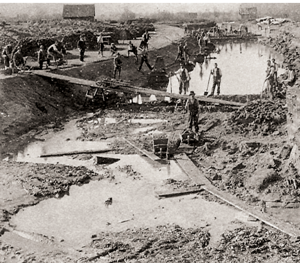
Abb. 6 | Erdaushub für einen Ennsdurchstich, Ende 19. Jhd. | Foto aus: Ein Tal im Wandel der Zeit 1984, S. 95
