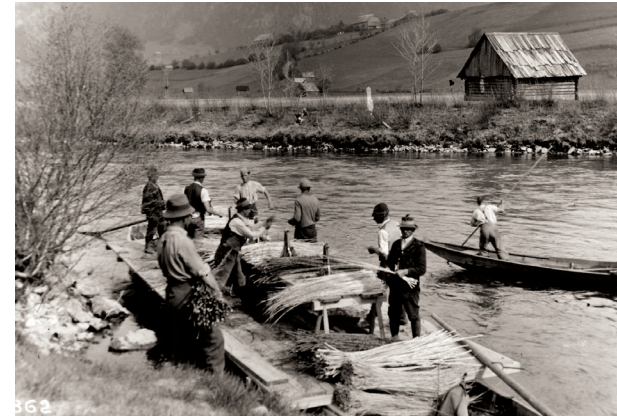
Abb. 8 | Ufersicherung mit Weidenbündeln
