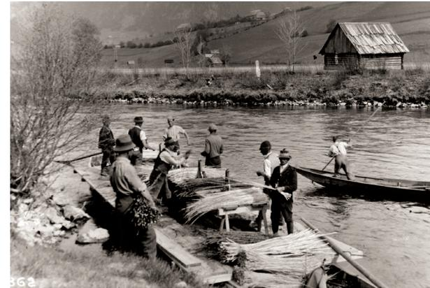
Abb. 8 | Ufersicherung mit Weidenbündeln
