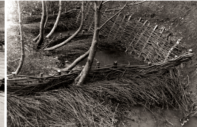
Abb. 9 | Uferbefestigung mit Weidenflechtwerk
