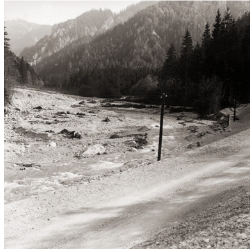
Abb. 2 | Gsengbrücke 2 – Kainzenalbl Quelle: WLW, GBL Unteres Ennstal und Salzatal 1951; Standort: hm 19,00; Blickrichtung Süd
