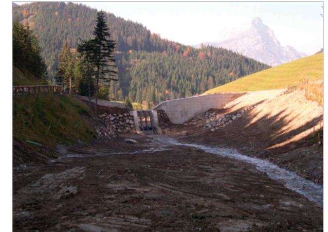
Abb. 8 | Sperre Retentionsraum
