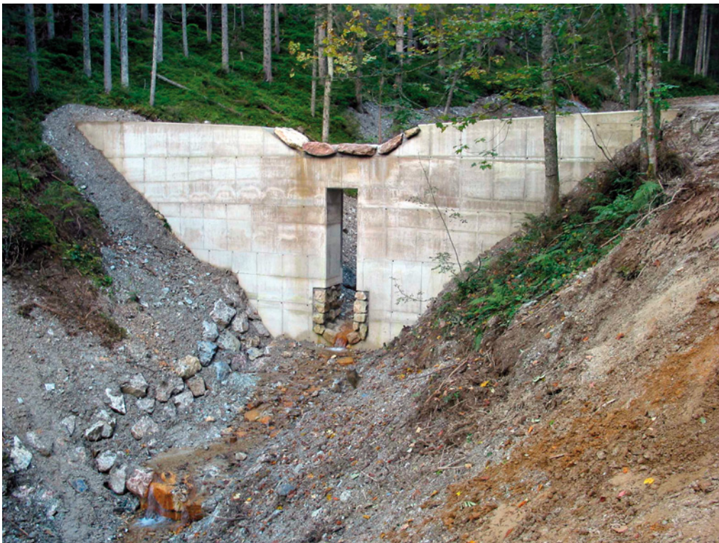
Abb. 10 | Scheibengraben, Stahlbetonsperre | Quelle: WLV, GBL Unteres Ennstal und Salztal 2005; Standort: Scheibengraben hm 0,55
