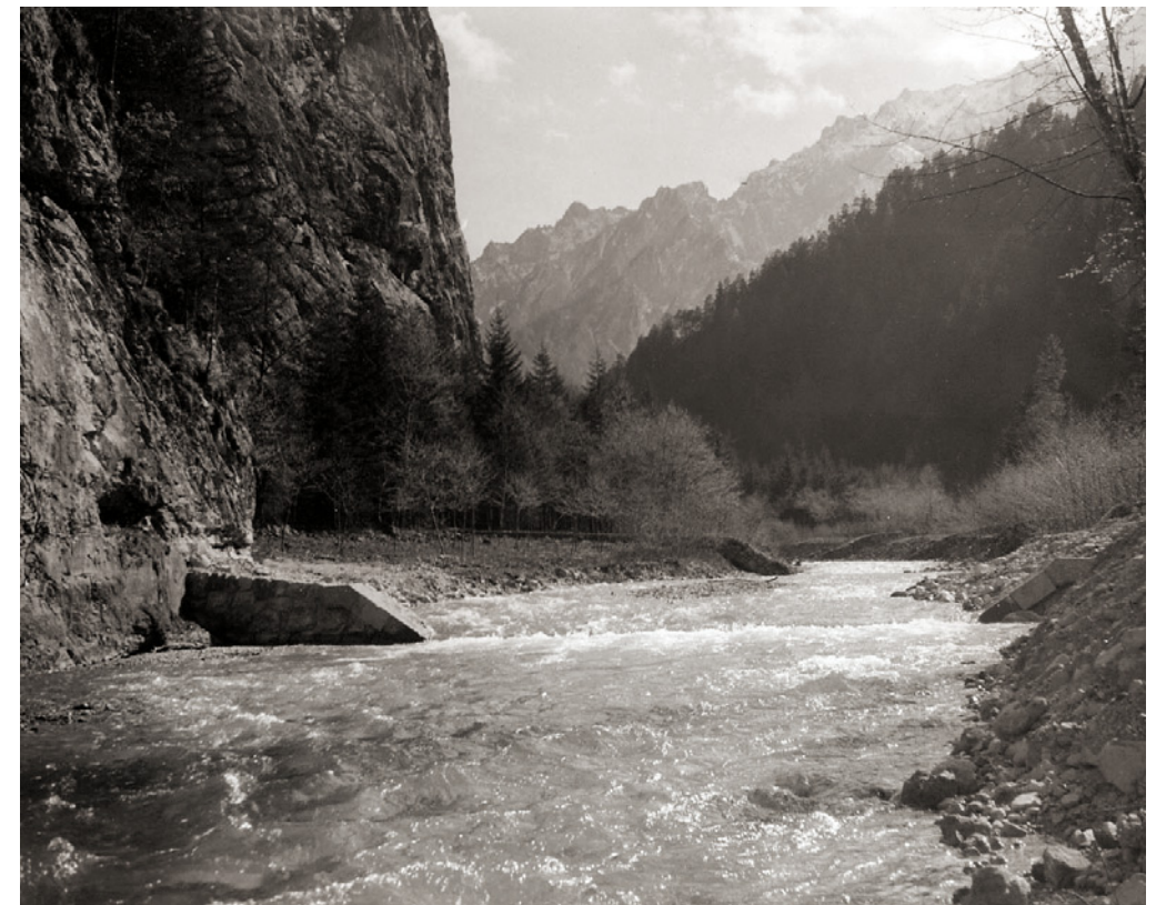
Abb. 7 | Sohlgurte bei „Helllichter Stein“ | Quelle: WLW, GBL Unteres Enns- und Salzatal, 1972; Standort: hm 7,80; Blickrichtung SSW
