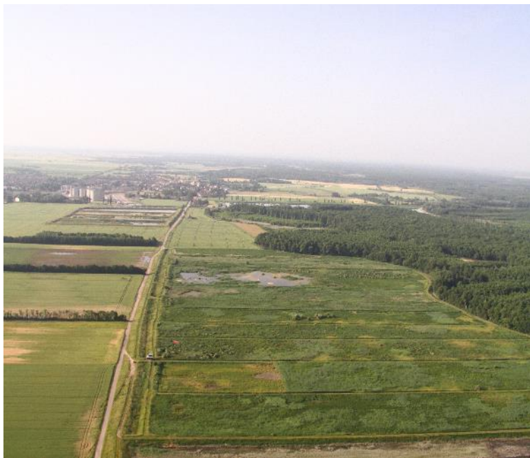
Abb. 3: Blick auf die Anlandebecken © M. Schmidt
