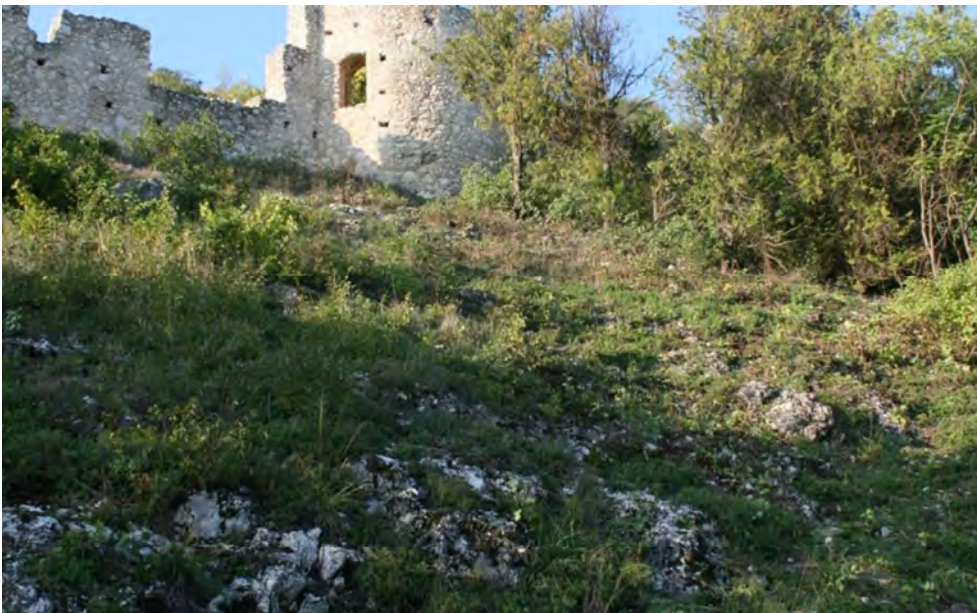
Abbildung 25. Staatzer Berg, Pflegefläche 2 unterhalb der Burgmauer (ost) – nachher. Foto G. Pfundner, 23.9.2017
