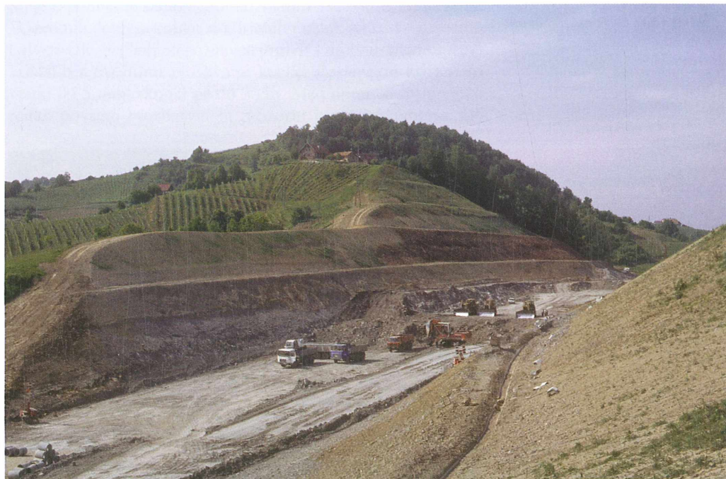
Usek pri Gornjem Štrihovcu tik pred zaključkom zemeljskih del junija 1996. Največ septarij so odkrili na delu, ki sega od električnega droga v obliki črke A do buldožerjev. Velikost septarij se je z globino manjšala. Višina posamezne terase je približno 8 m. Foto: Mirjan Žorž
