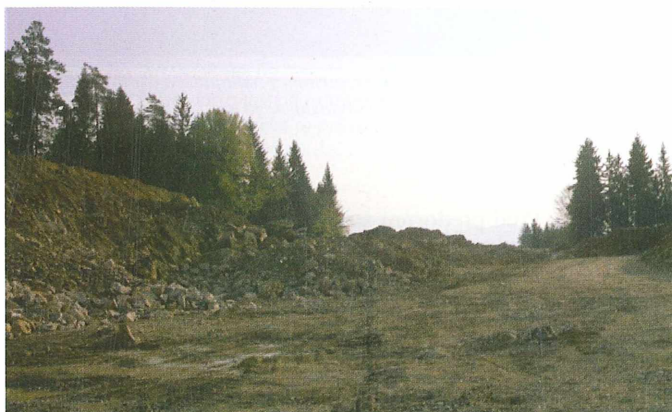
Gradbišče avtoceste na Boštajevega hribu – pogled proti Krtini septembra 2000. Foto: Mirjan Žorž
