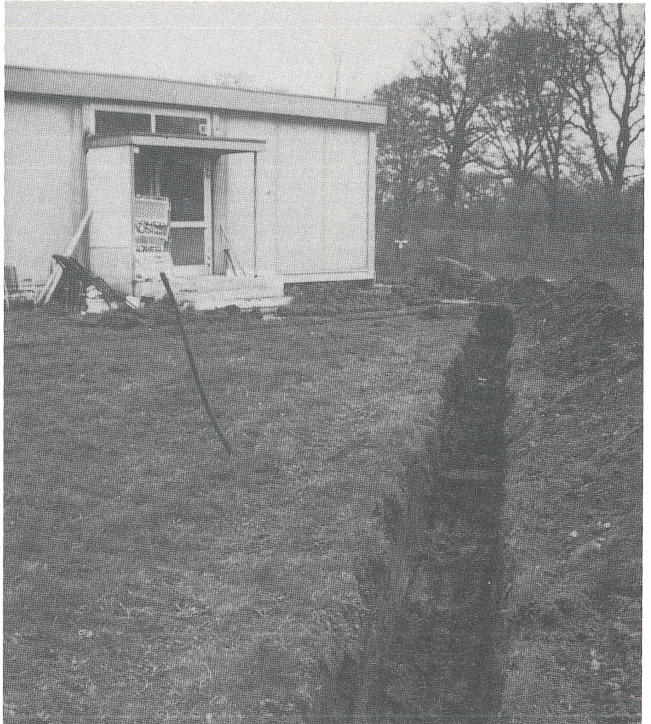
Die Leitungen für die Gasheizung können verlegt werden.
