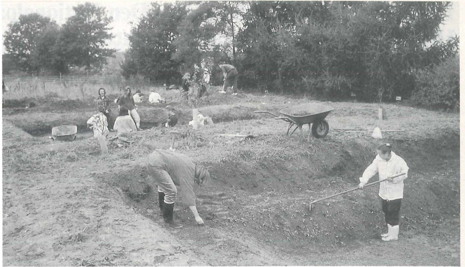
Das Teichprofil erhält den letzten Schliff; spitze Steine werden abgesammelt.
