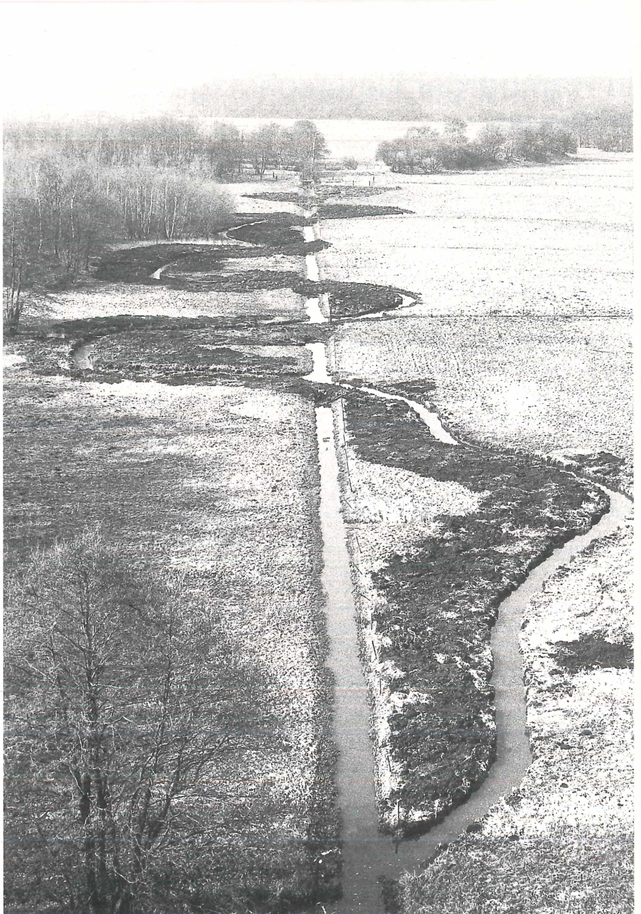
Abb. 2: Der 1982 fertiggestellte 1. Bauabschnitt des wiederhergestellten, ehemaligen Wandselaufes, eines trägen Wiesenbaches, kurz nach der Baumaßnahme.
