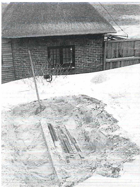
Die versandete Solaranlage vor der Vogelwärterhütte auf Amrum. Foto: Dieter Kalisch
