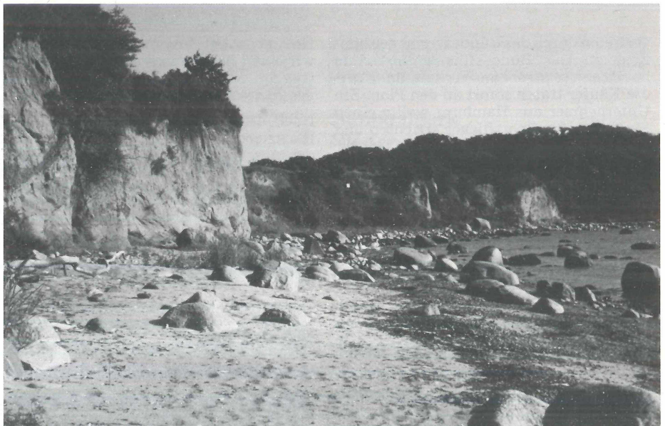
Die Abbruchkante an der Ostküste.
