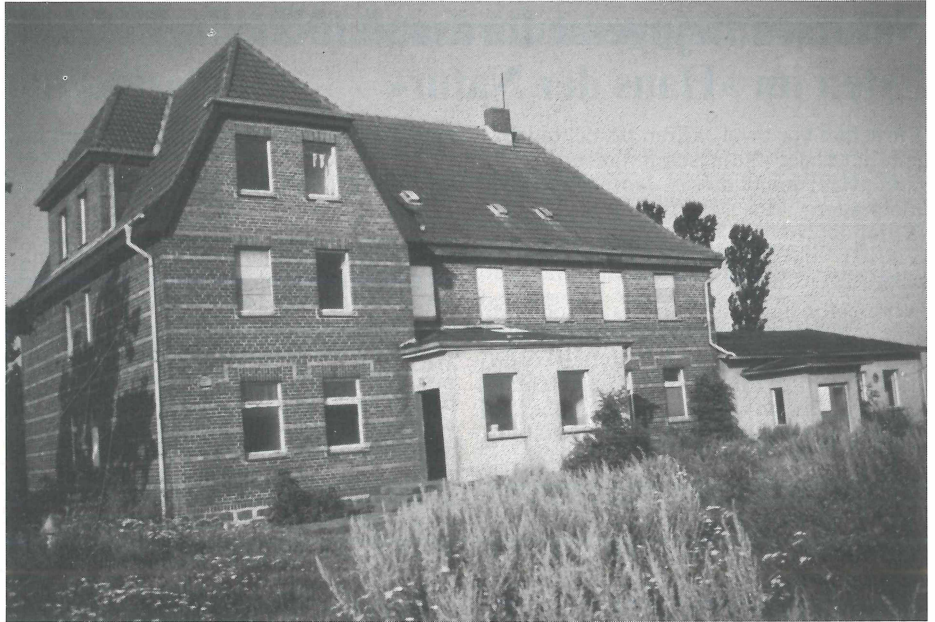
Der Inselhof nach der ersten Fenstersicherung.
