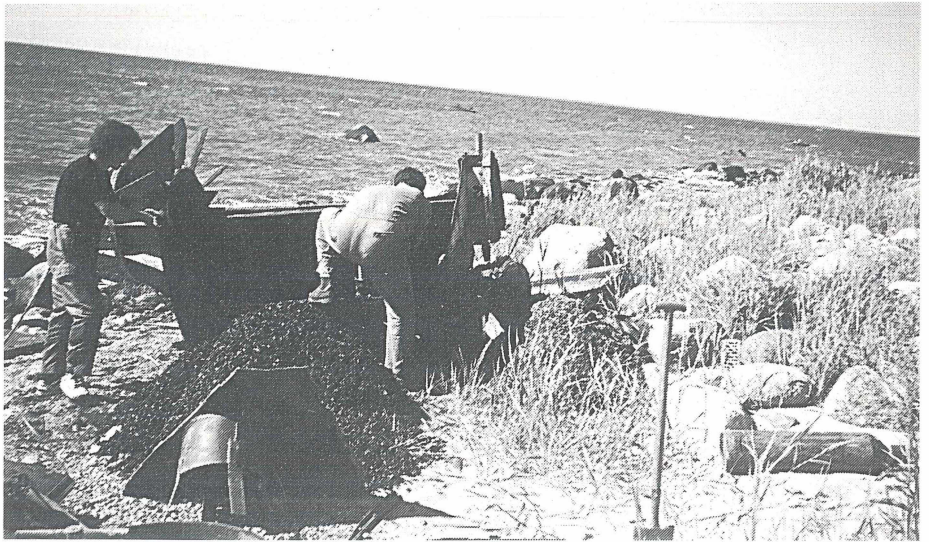
CJD-Mitarbeiter bei Aufräumarbeiten am SE-lichen Blockstrand.
