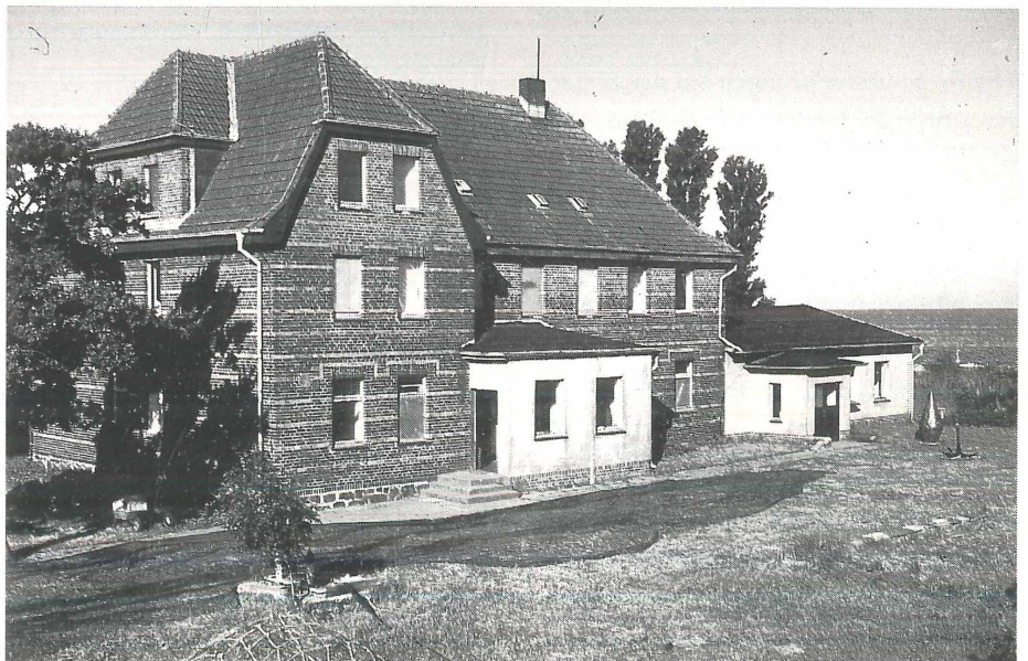
Inselhof mit zerstörten Fenstern.
