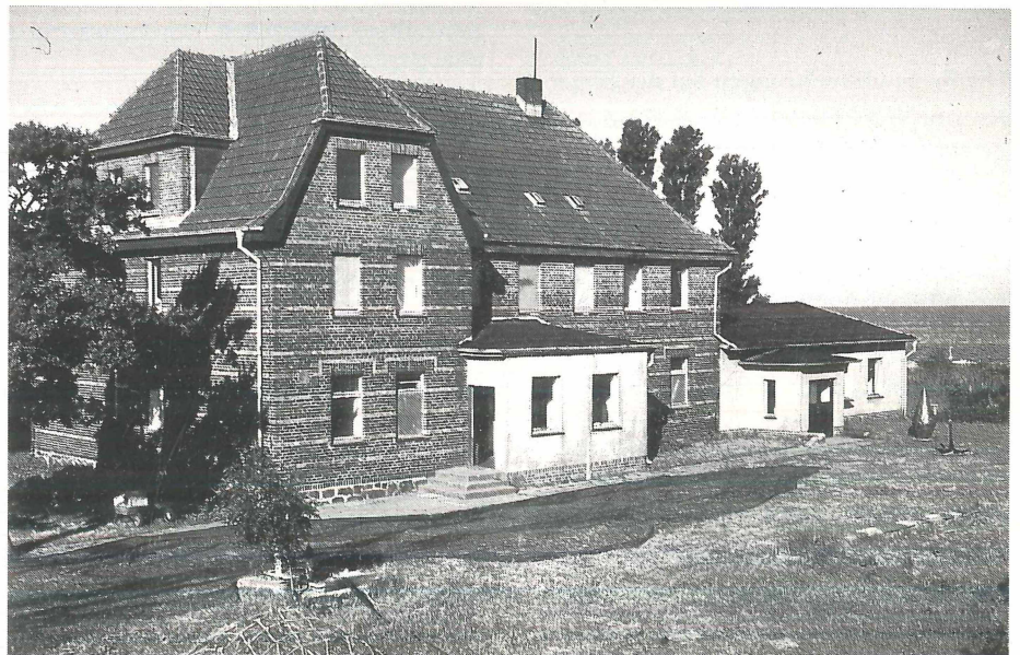
Inselhof mit zerstörten Fenstern.
