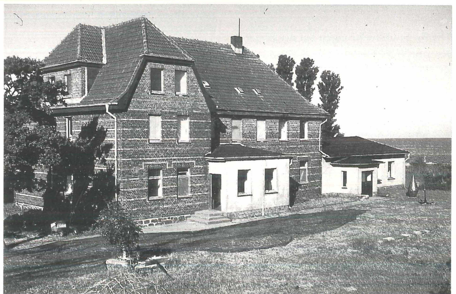
Inselhof mit zerstörten Fenstern.
